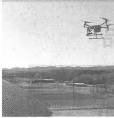
ドローンを活用し工場の保守点検で省力化をはかる
